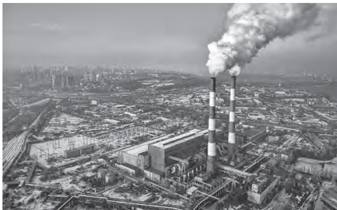
Рис. 15.1. Загальний вигляд Київської ТЕЦ-5 узимку
