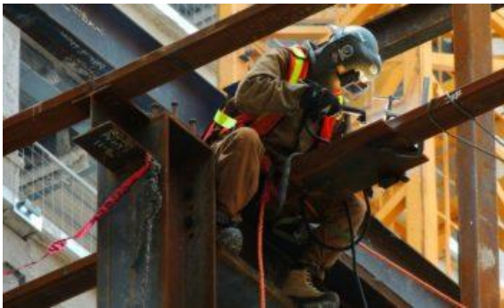
Рис.5.3. Виконання зварювання на висоті із застосуванням запобіжного поясу
