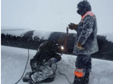
Рис.4.6. Виконання зварювальних робіт у незручному положенні та у несприятливих метеорологічних умовах
