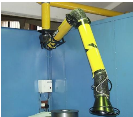
Рис.3.3. Місцевий витяжний пристрій вентиляції
