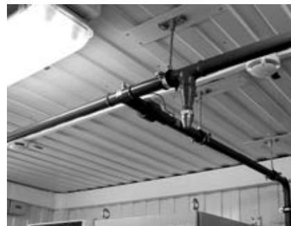
Рис. 62 Монтаж спринклера
