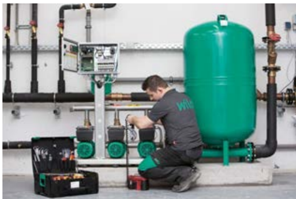
Рис. 58 Монтаж розширювального бака
