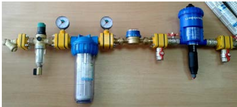
Рис. 48 Монтаж фільтрів у системі водопостачання
