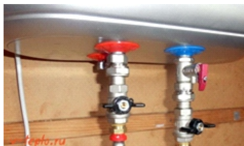
Рис. 104 Схема підключення накопичувального бойлера
