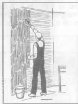
Рис. 6. Розтушовування ґрунтовки
