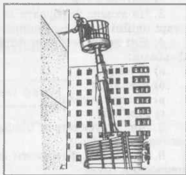
Рис. 46. Фарбування фасадів фарборозпилювачем з автомобільної вишки
