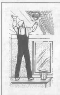
Рис. 13. Нанесення клейової суміші на стелю
