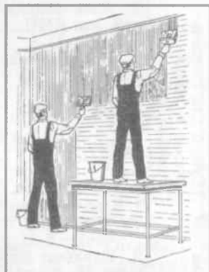
Рис. 15. Клейове фарбування стін вручну
