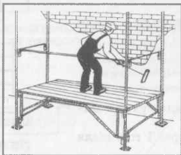
Рис. 45. Фарбування фасадів валиком
