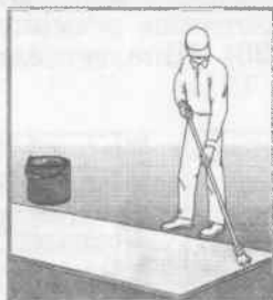
Рис. 115. Нанесення клею на підлозі маховою щіткою
