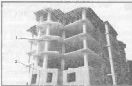
Рис. 39. Будівництво монолітно-цегляного будинку: 1 – монолітний каркас; 2 – цегляна стіна
