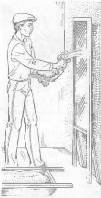
Рис. 45. Виконання набризку через сітку
